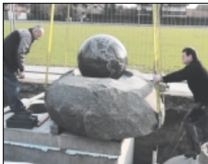
Ein Spezialkran hievte die tonnenschweren Bauteile
