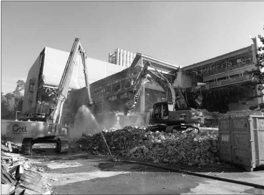
Abbruch einer Halbleiterfabrik in Böblingen mit Longfront-Baggern.
