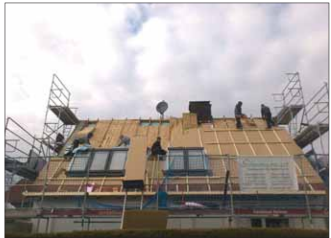
Die Stapelfeldts bei der Arbeit: „Man sieht am Ende, was man geschaffen hat. Wenn wir durch Alling fahren, kommen wir immer wieder an Dächern vorbei, die wir gemacht haben und freuen uns daran!“
